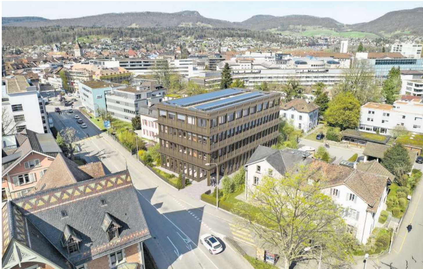
Die Aargauische Industrie- und Handelskammer (AIHK) plant an der Entfelderstrasse 11 in Aarau einen Ersatzneubau.
